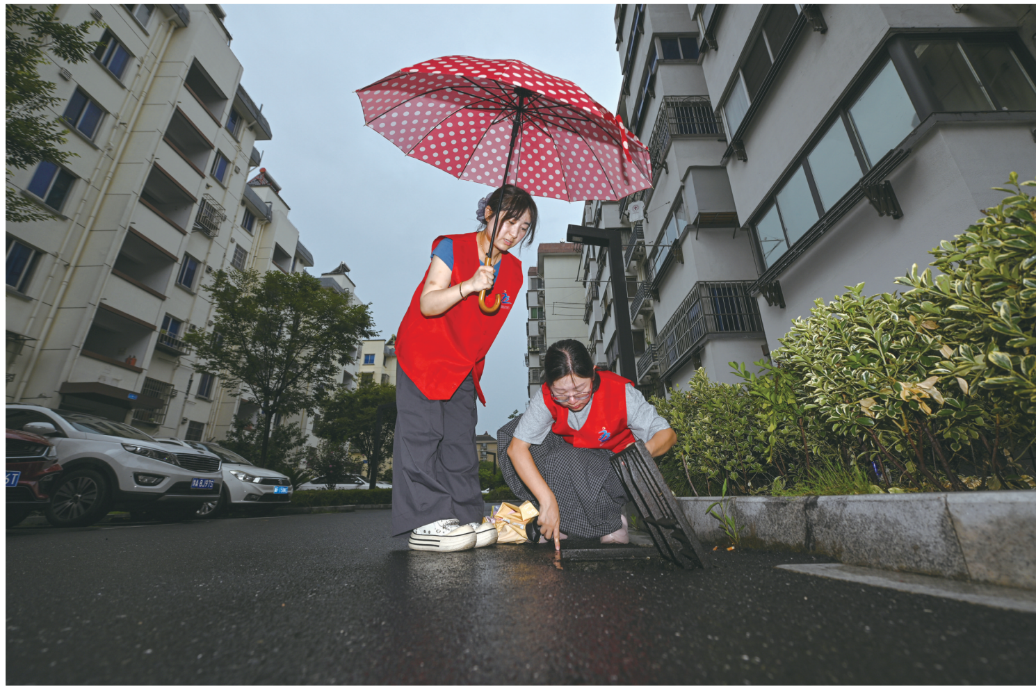
南湖区禾兴街道西马桥社区组织工作人员排查安全隐患。
