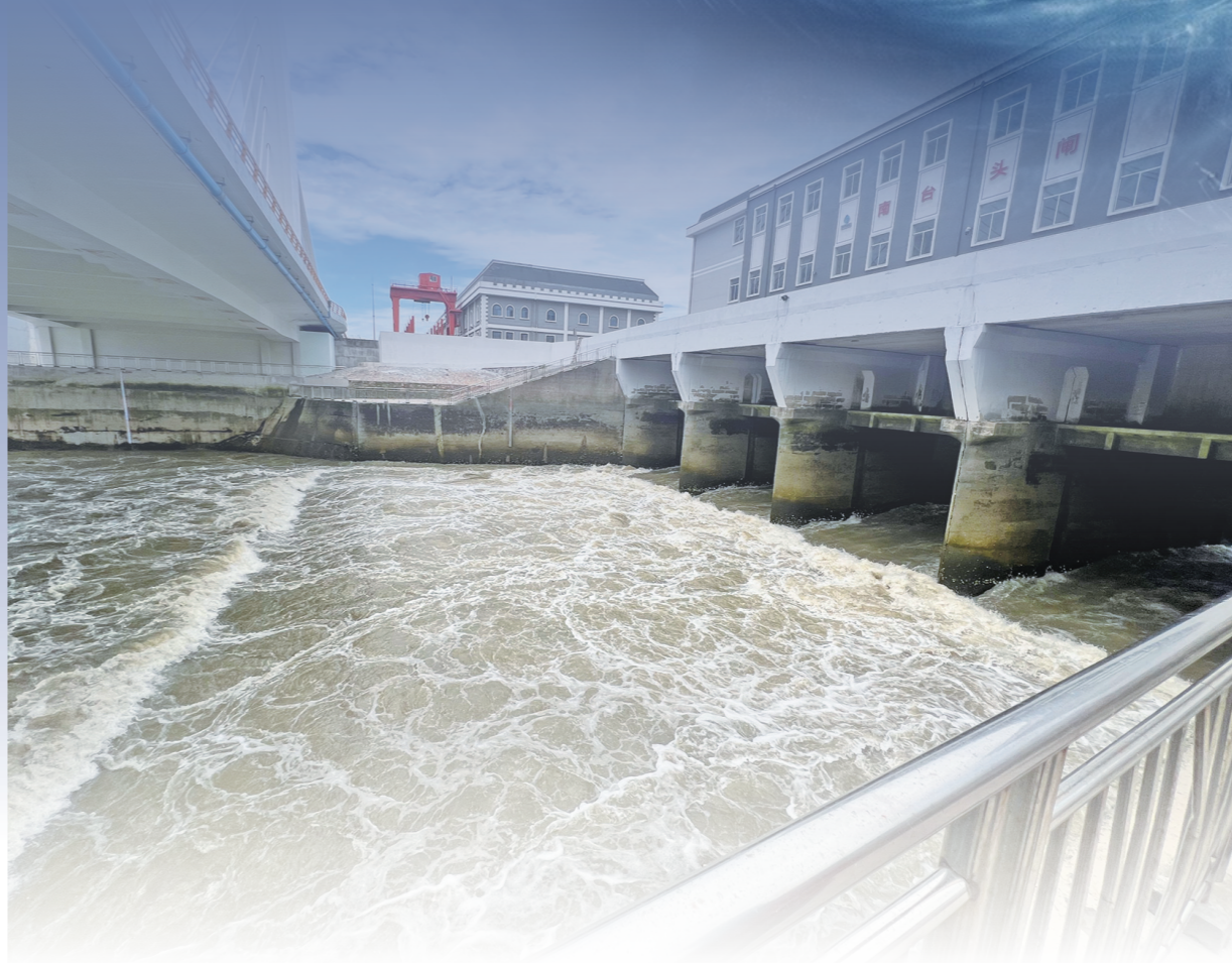
南台头闸全力投入排涝作业。图片由水利局提供
