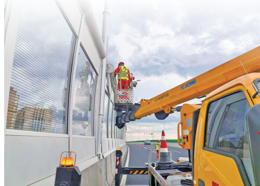
市政工作人员对高架道路的隔音屏障进行加固检修作业。 图片由市建设局提供
