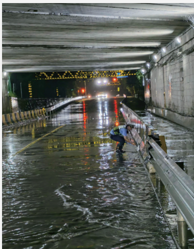
在隧道积水区域清理下水道堵塞物
